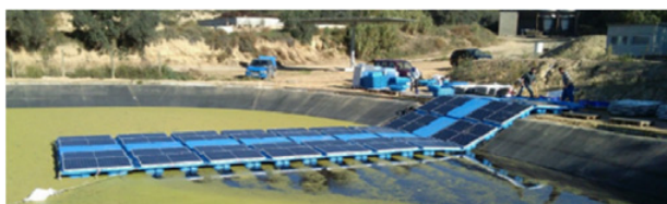
Figura 12. Conjunto fotovoltaico flotante, durante su montaje.
