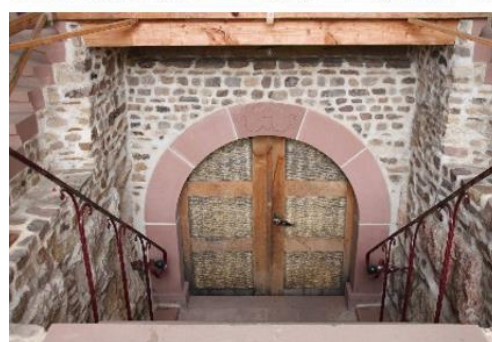
Figure 19. Exemple d'approche bioclimatique, en harmonie avec l'architecture locale au sein du Domaine Léon Boesch en Alsace, La cave est enterrée, en enrochement non scellé. Les espaces au-dessus sont agencés de façon à ce qu'elle soit protégée de l'ensoleillement du sud. Un toit végétalisé a été créé au Sud, tandis que la plus grande façade est au Nord. www.domaineboesch.fr , photos J. Rochard.
