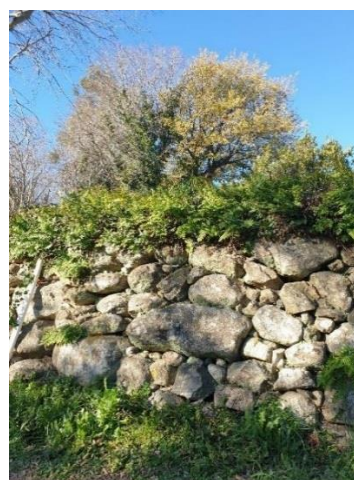
Photo 2. Terrasse de blocs de pierre à Laroque des Albères dans le Roussillon, photo J. Rochard.
